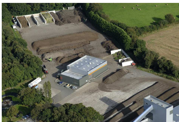
Illustration 16 : Installation du SMITRED à Pleumeur-Bodou (Crédit photo : Valorys)
