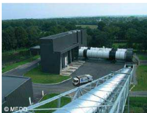
Illustration 15 : Installation du SMITOM Launay-Lantic (Crédit photo : MEDD)
